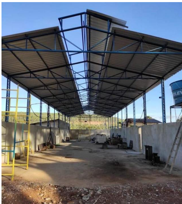
Porto Indústria de Papel e Artefatos Obras de construção da fábrica
