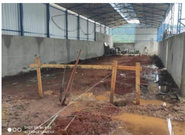
Porto Indústria de Papel e Artefatos Obras de construção da fábrica
